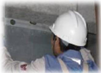
Ajuste la posición para asegurarse de que los espacios entre el cuerpo y los cuatro lados del techo sean uniformes. La parte inferior del cuerpo debe hundirse en el techo entre 10 y 12 mm. En general, L es la mitad de la longitud del tornillo del gancho de instalación.
